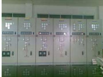
Gambar 5. Bentuk fisik panel kontrol gardu induk
