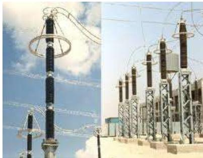
Gambar 4. Bentuk fisik arrester pada gardu induk
