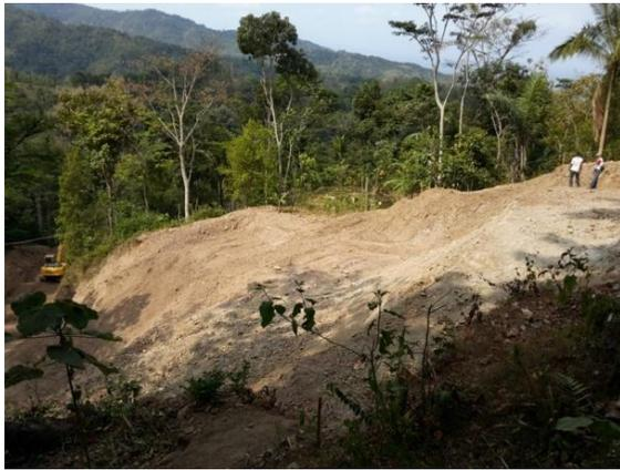
Gambar 1. Timbunan Tanah penutup dengan Kemiringan Lereng Timbunan 30°
