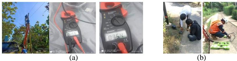
**Gambar 3.** a) Pengukuran Hambatan *Bushing* Sekunder Trafo Menggunakan Ohm Meter
