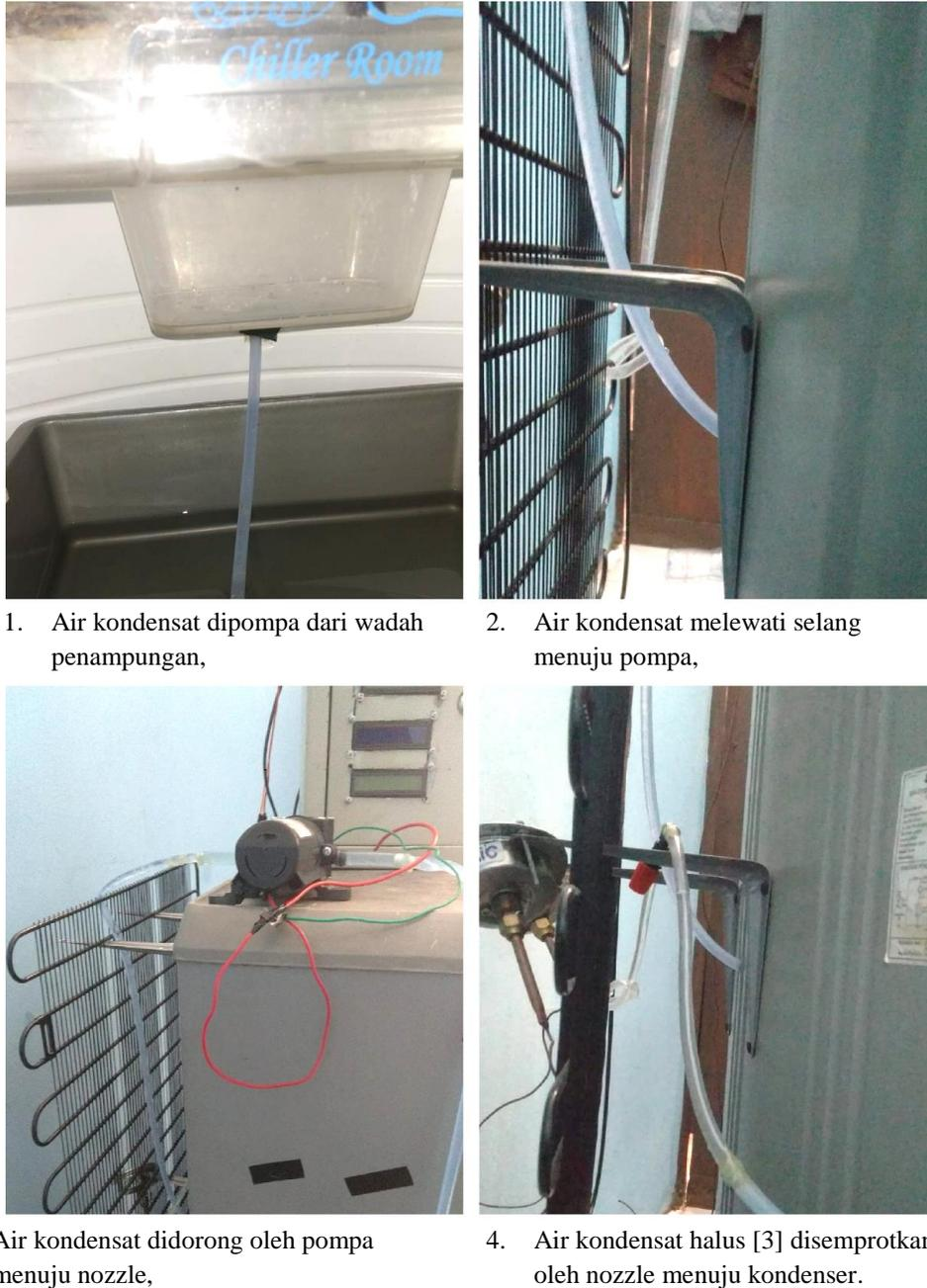
**Gambar 3.** Proses Penyemprotan pada Kondenser
