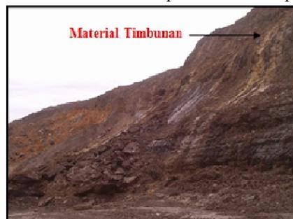
Gambar 5.5 Material timbunan penyusun lereng
